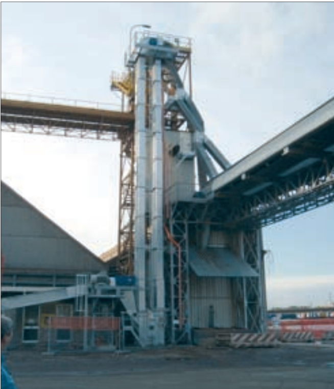
Casing & Buckets - Gehäuseschacht und Becher - Tuyau et godets - Canna e Tazze
